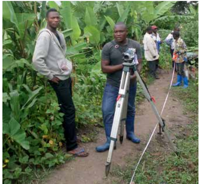
Vermessungen vor der Verlegung: Gemeinsam mit der Gemeinde wurde das Wasserversorgungsnetz gebaut.
